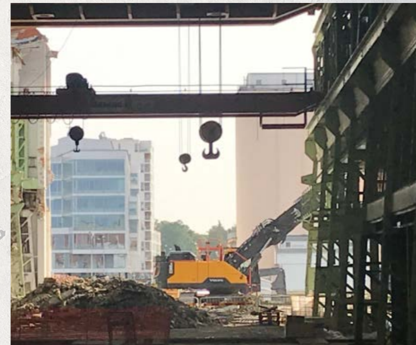
Bilden till vänster; rivningsarbete där krokarna fortfarande var på plats i Maskinverkstaden. En krok kunde lyfta hela 250 ton! Foto: Varvsstaden.
