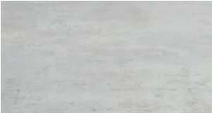
Vit rå betong, 641
