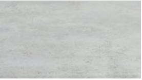
Vit rå betong
