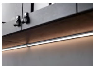
Led ljusramplista, dimbar Armatyr samt eluttag monteras under väggskåp
