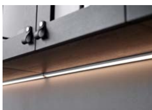
Led ljusramplista, dimbar Armatur samt eluttag monteras under väggskåp
