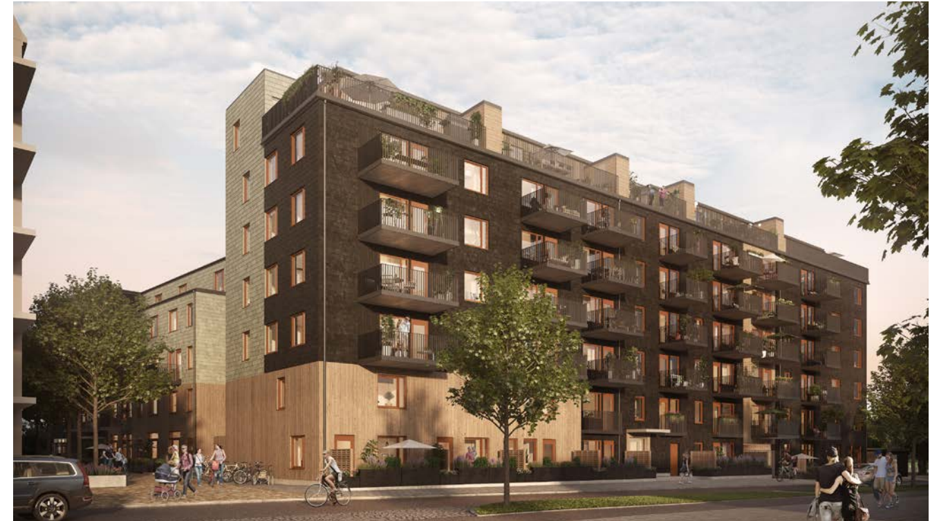
I Hyllie Homes har alla lägenheter balkong, terrass eller uteplats. Vy från Skrivaregatan.
