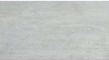
Vit rå betong, 641
