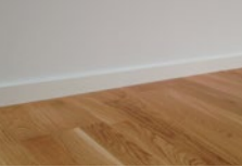
Vit, NCS S 0500-N Sockel och foder levereras fabriksmålade med synliga spikhuvuden
