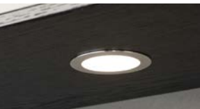
Infällda spotlights i LED.
