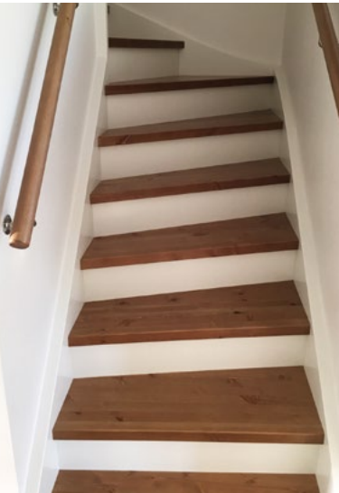
Plansteg och handledare i eklaserad furu, i övrigt vitmålad, tät trappa
