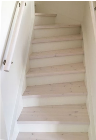
Plansteg och handledare i vitlaserad furu, i övrigt vitmålad, tät trappa
