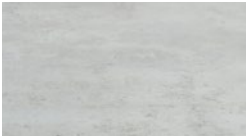
Vit Rå Betong
